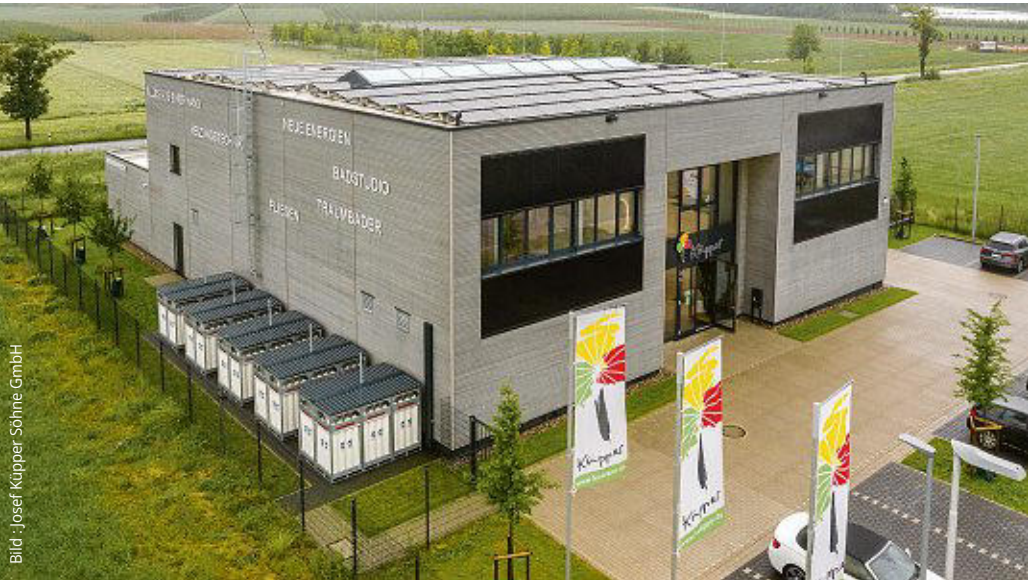
Der dritte Standort der Firma Küpper in Meckenheim. Der Strom aus der Photovoltaikanlage kann in Wasserstoff umgewandelt und in Druckflaschen für den Winter gespeichert werden
